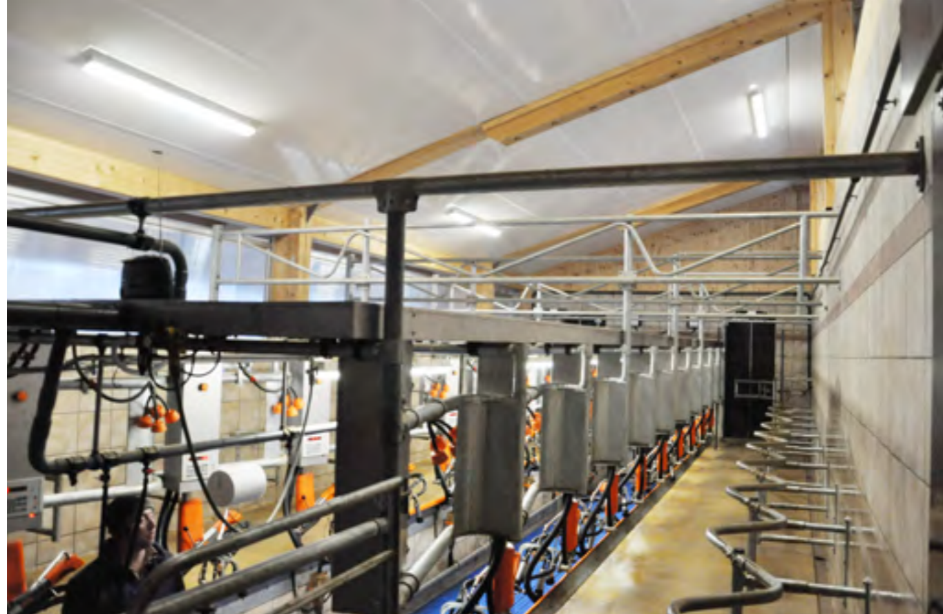
Feuchtraumleuchten TGL mit opaler Abdeckung erhellen Raum und Decke einer großen Melkanlage mit 210° Abstrahlwinkel
