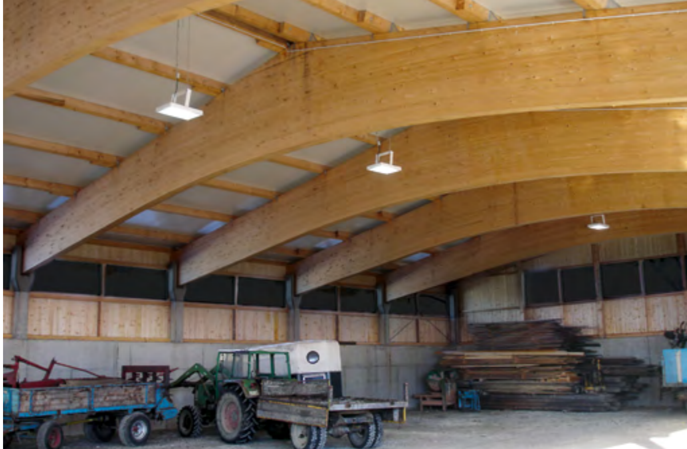
Dank großem Abstrahlwinkel genügen nur wenige SHL Strahler, um diese Bergehalle großflächig auszuleuchten
